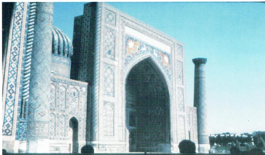
Foto 2 : En lo macro: volúmenes puros organizados según un patrón compositivo riguroso, en lo micro: multitud de tramas geométricas secundarias articulando el conjunto, y dándole unidad. Fachada de la madrasa de Ulugbek (Samarcanda, 1420), Nótese la ligera curvatura del fuste del minarete destinada a corregir ópticamente las visuales, tal como hacían los griegos en sus obras arquitectónicas de la antigüedad clásica
