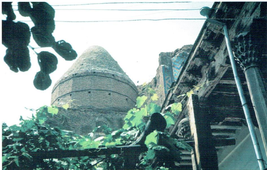
Foto 8 : En esta cúpula de una madrasa del s.IX ubicada en la ciudad de Tashkent se puede observar una forma primitiva de resolución de una cúpula, ésta es en realidad un cono y se apoya sobre un tambor no cilíndrico sino de generación en dodecaedro.
